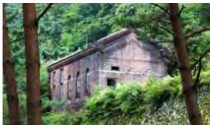
第三変電所跡
