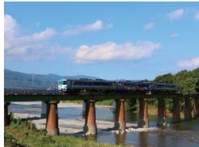
赤煉瓦の鉄橋を渡るアンパンマン列車
