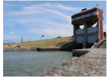
源流風景 (⑫新町樋門)
