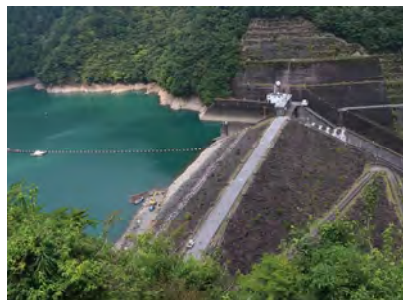
展望台から魚梁瀬ダム堰堤を見下ろす
