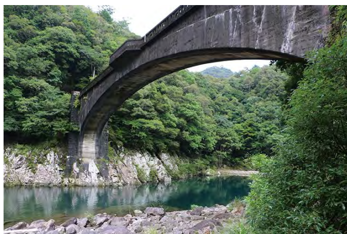
奈半利川河原から堀ヶ生橋を見上げる
