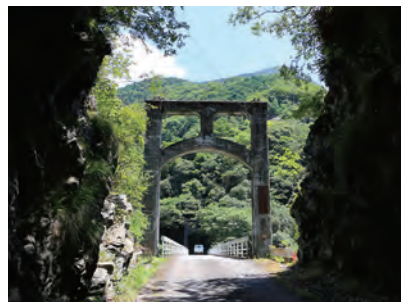
つり橋の支柱が残る止呂橋
