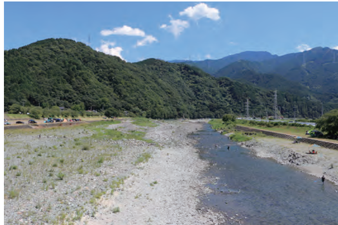
伊曾乃橋（通称：メロディー橋）から武丈公園がある上流部を望む
