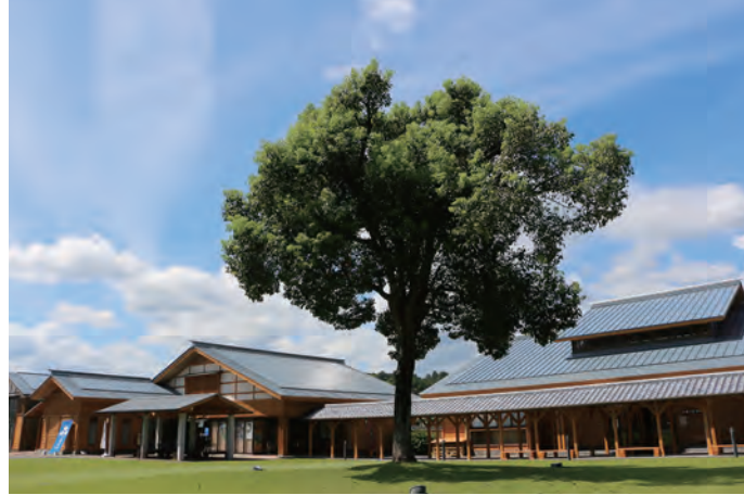
中庭から見た三幸館といきいき館の全景
