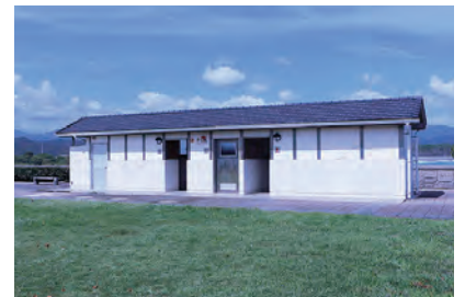
鞆奥漁港海浜公園のトイレ・シャワー施設
