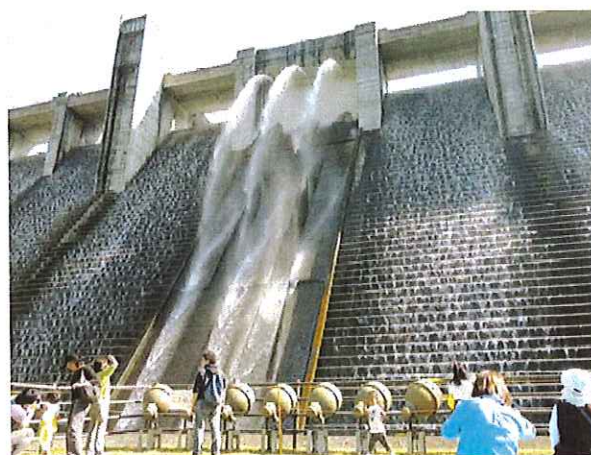
ダム洗浄放水
