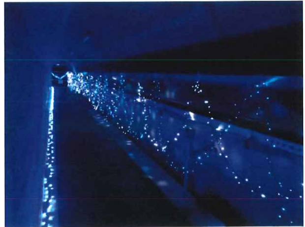
ダム内部イルミネーション
