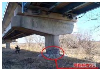
▲耐震補強なしの橋脚
