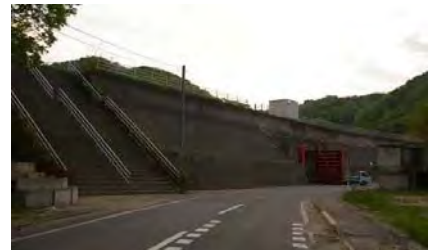
▲上流にある集落への津波被害を防いだ太田名部地区防潮堤
