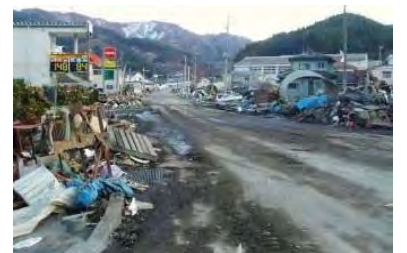
▲2車線交通路確保(3月12日撮影)
