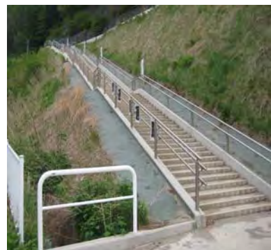
▲小本小学校の体育館裏から伸びる国道45号へ続く避難階段
