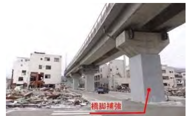
▲耐震補強済みの橋脚
