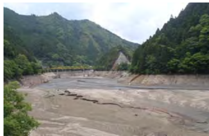
▼出合橋上流より
