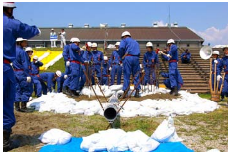
▲漏水の吹出口に土嚢を積み貯水し、その水圧で噴出を抑える漏水対策工（釜段工）
