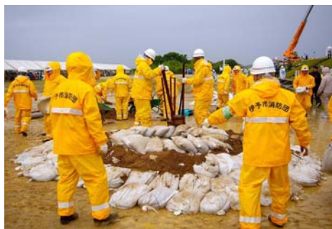
▲土嚢を使つての釜段工
