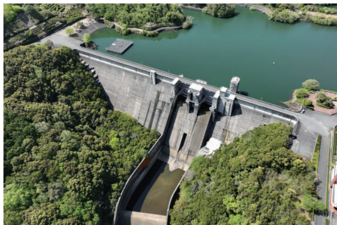
野村ダム(重力式コンクリートダム、堤高60m、堤頂長300m)
