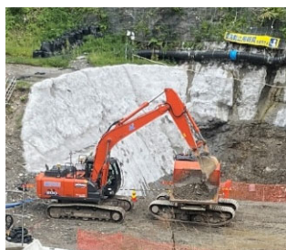
運搬用の建設重機への 土砂積み込み
